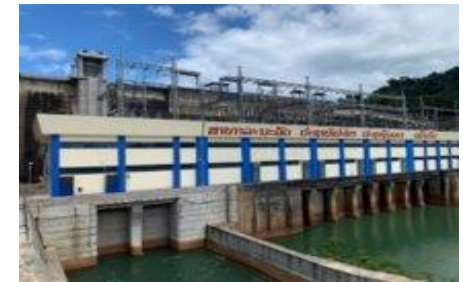
ラオス: 拡張されたナムグム第1水力発電所
