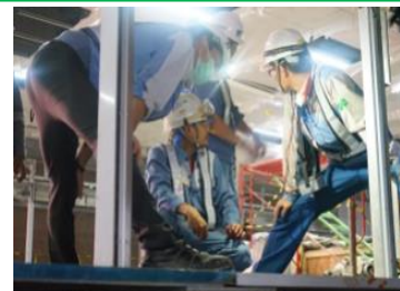
インドネシア:都市高速鉄道の建設
